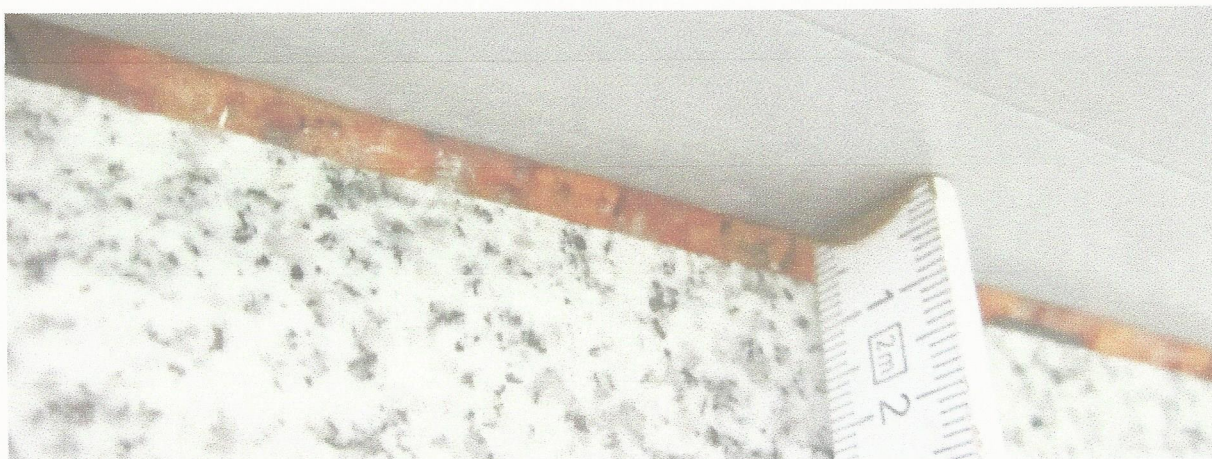
Rys. 24. Deformacja okien na skutek złego mocowania
