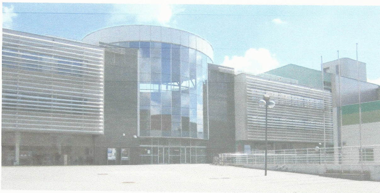
Rys. 2. Widok elewacji frontowej Wydziału Prawa i Administracji UŚ
