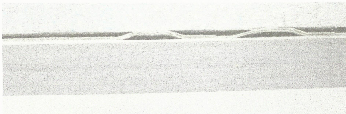
Rys. 20. Rozszczelnienie dylatacji między segmentem środkowym i południowym
