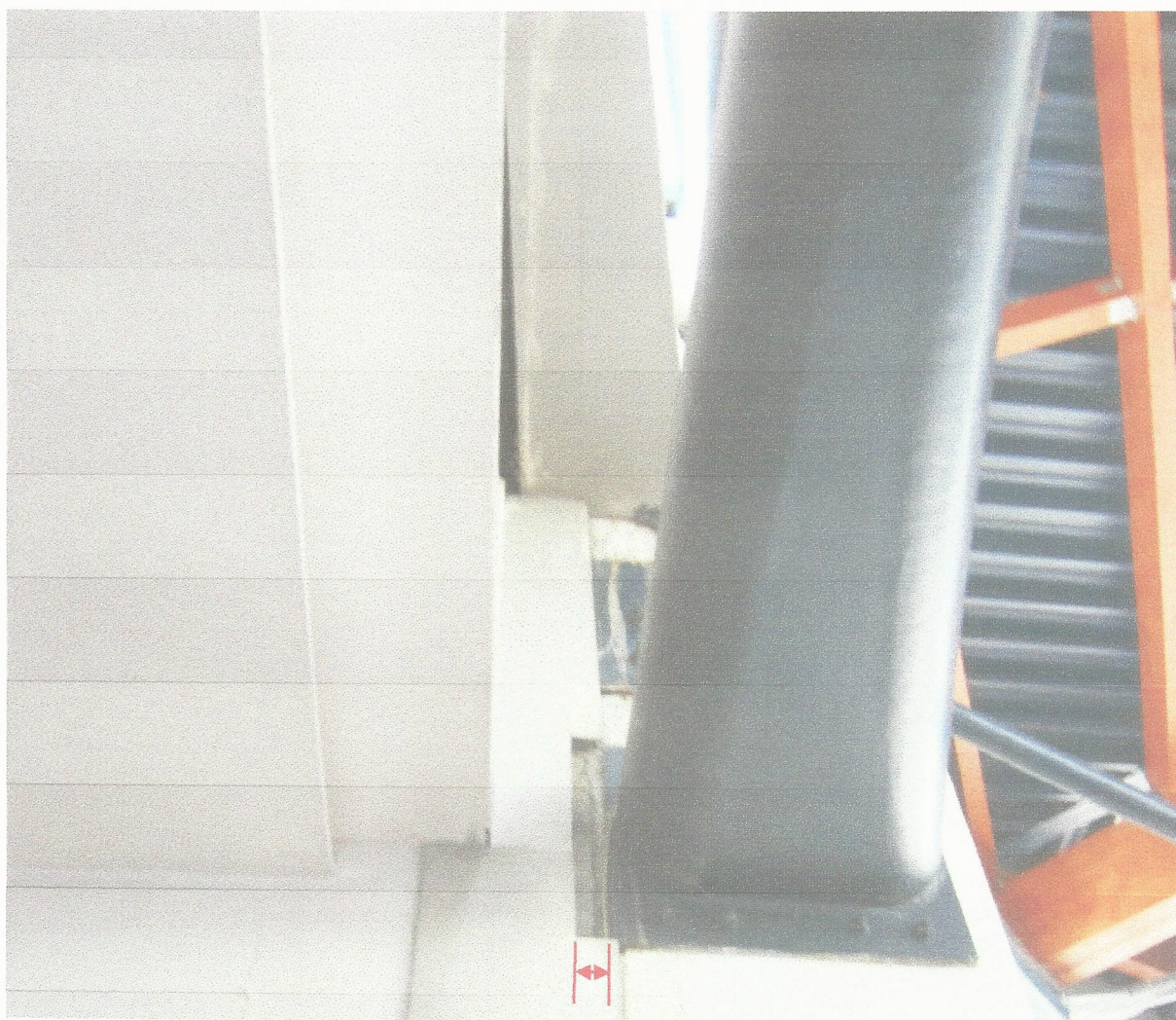
Rys. 16. Przesunięcie listwy maskującej między segmentem środkowym i południowym
